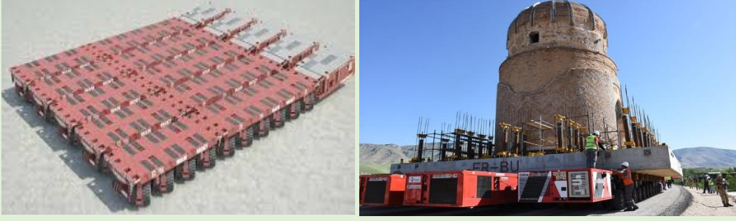
Resim 1.3/4. Zeynel Bey Türbesini Taşıyan Özel Yapım SPMT ve Taşıma süreci
